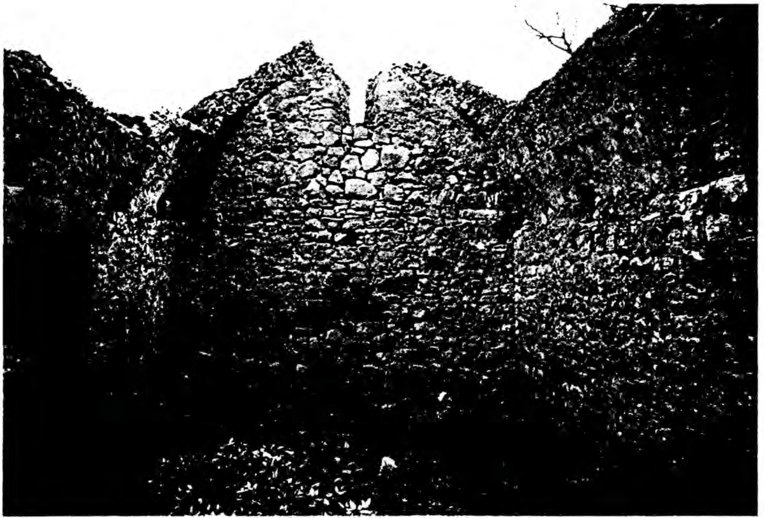
Santa Maria in Altissimis, interno dell'aula absidata con tracce della volta di copertura
