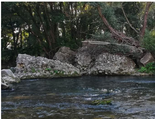
L'opus caementicium della parte interna delle pile
