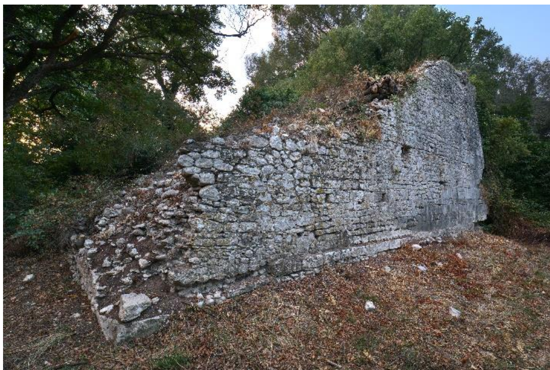
Ponte Latrone - Pila sud
