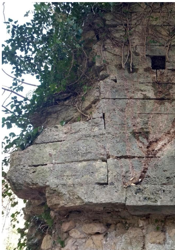
Pila sud – Particolare dell'arco
