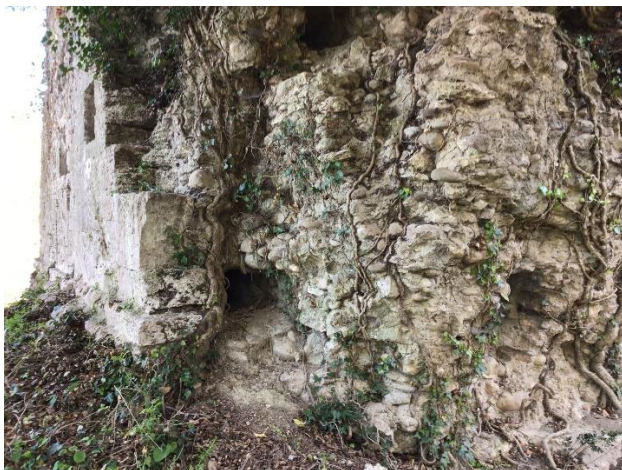
Pila nord – Particolare dei fori di alloggiamento degli appoggi per le centine
