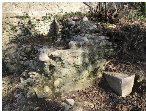
Pila nord – Fondazione in opus caementicium e relitto dello sperone di valle
