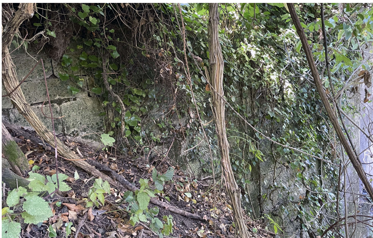
Ponte Latrano, lato a monte. È ancora presente, sebbene rimaneggiato, il paramento esterno
