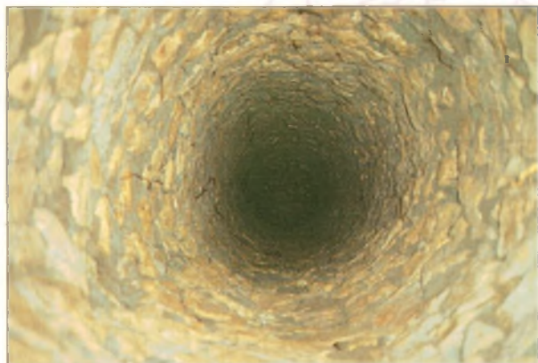
2 - Lo spiramen visto dall'esterno. (foto P. Palazzo)
